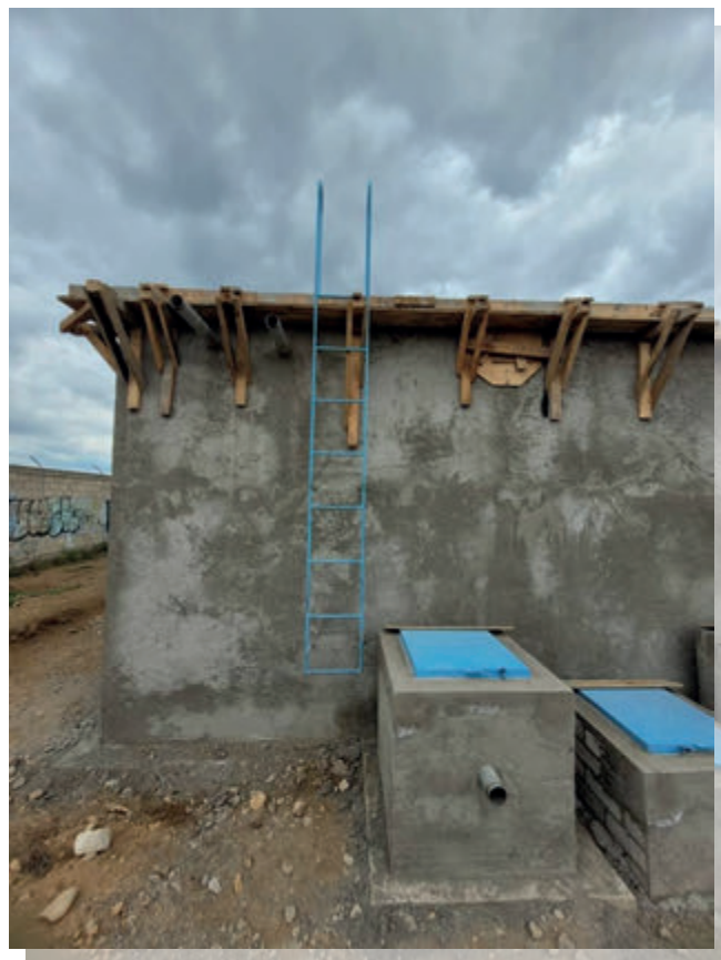
Construcción de Tanque de Agua Entubada .
