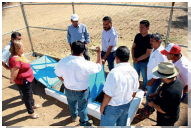
Construcción de Cárcamo en el barrio de San Lucas del Municipio de Cuilápam de Guerrero.
