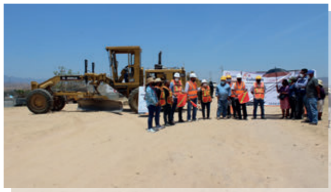
Rehabilitación de Caminos Rurales en el Municipio de Cuilápam de Guerrero.
