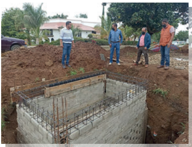
Construcción de Pozos de Absorción en el Municipio de Cuilápam de Guerrero.
