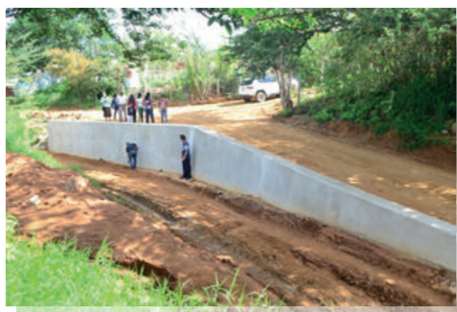
Construcción de Muro de Contención en el Paraje La Guamuchalera, Arroyo Seco en el Barrio Guadalupe, 3ª. Sección.
