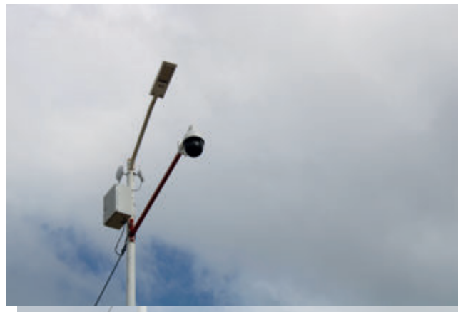
Instalación de Video Cámaras de vigilancia (Primera Etapa).
