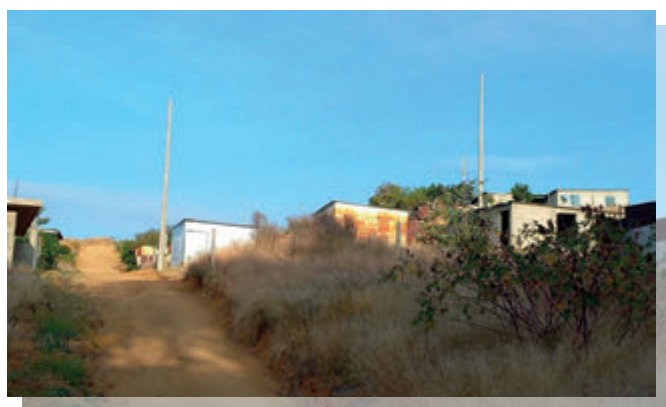
Ampliación de la R.D. en la colonia Tepeyac, en el Municipio de Cuilápam de Guerrero.
